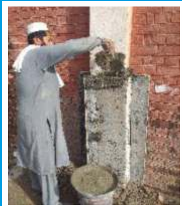
Pour 1:2:4 concrete using pan
